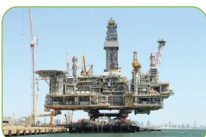
"Azəri-Mərkəzi-Şərqi" platformasının üst modulunun dənizə yola salınması – "STB-1" barji
